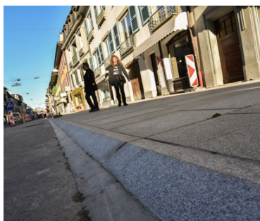
Les travaux dans la Grand-Rue se terminent fin août. Les autorités se félicitent d'avoir respecté les délais. ARCHIVES CÉDRIC SANDOZ
